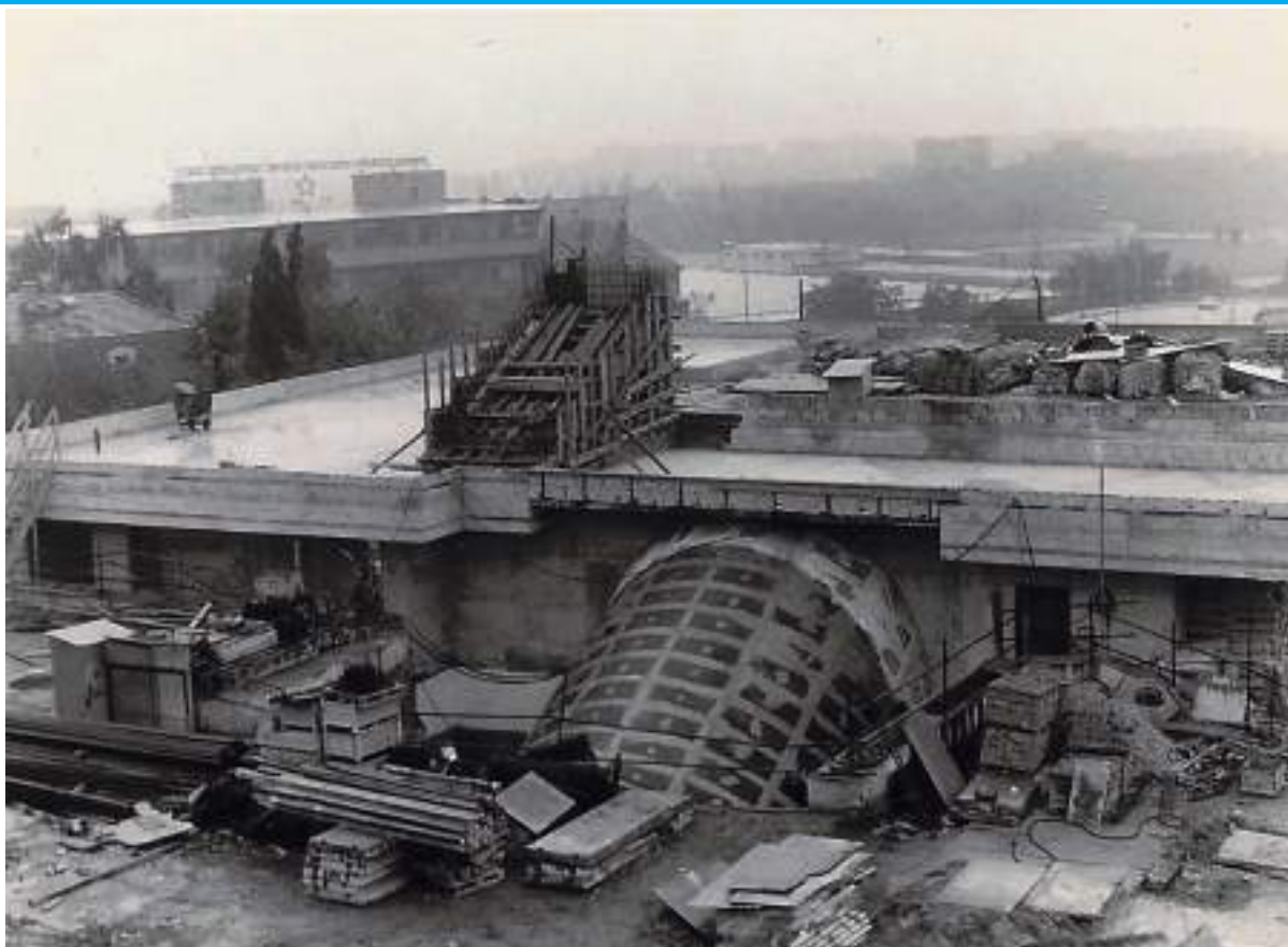
STAVBA METRA ŠVERMOVA (DNEŠNÍ JINONICE) ROK 1986 – 87.
