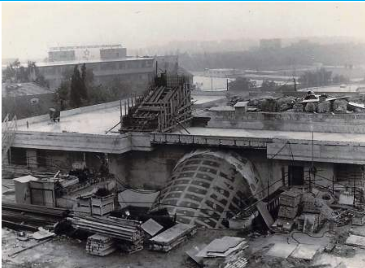
STAVBA METRA ŠVERMOVA (DNEŠNÍ JINONICE) ROK 1986 – 87.
