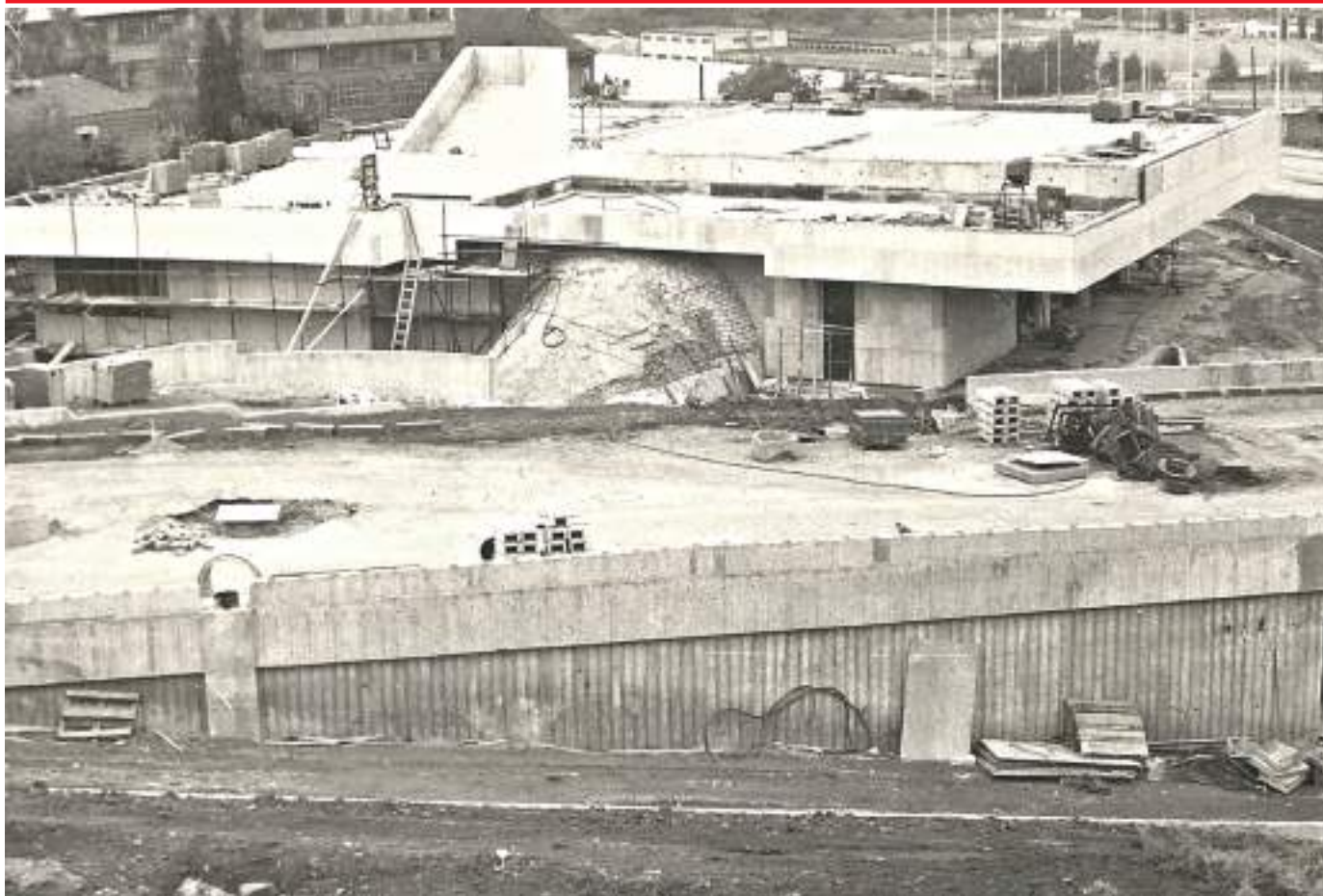
STAVBA METRA ŠVERMOVA (DNEŠNÍ JINONICE) PODZIM 1987.
