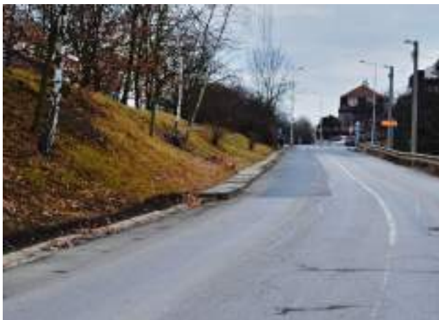
SOUČASNÝ STAV PANELOVÉ „CESTY“.
